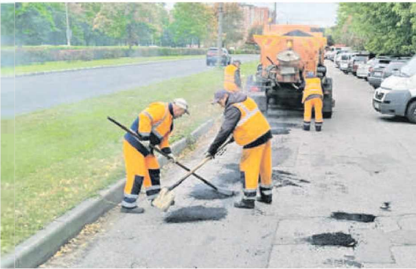
Белкинской, Звёздной и Ленина. Ямочный ремонт провели на площади 169 кв. метров.
