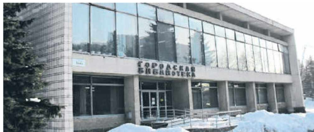
«СТЕКЛЯШКА» И БИБЛИОТЕКА «СТАРЫЙ ГОРОД» ЖДУТ СВОЕЙ ОЧЕРЕДИ НА РЕМОНТ
