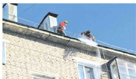
В Калужской области пройдёт проверка крыш многоквартирных домов. Такое за-
